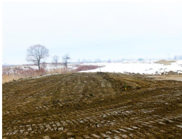
Тий бокс по време на реконструкцията
